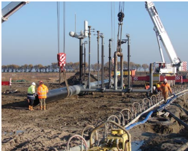
La posa del metanodotto
